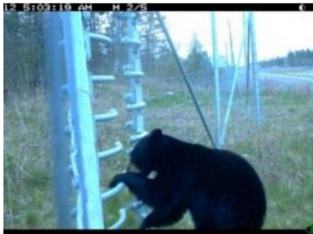
Figura nr. 2-14 Exemple ale unor porți de ieșire pentru fauna sălbatică ajunsă în zona carosabilului autostrăzii
