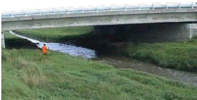
Figura nr. 5-6 Exemplu al unui pod care menține malurile naturale ale râului pe care îl traversează (Iuell, 2003)
