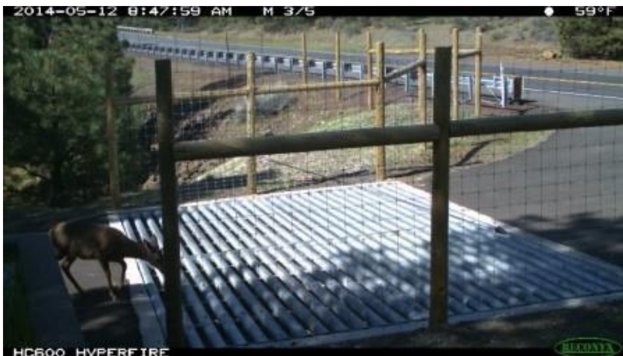
Figura nr. 5-22 A. Exemplu al unui grilaj electricizat pentru fauna sălbatică; B Exemplu al unui panou de avertizare montat pe un drum din Țara Galilor pentru a atenționa șoferii cu privire la prezența unui grilaj; C. Grilaj instalat pentru a evita pătrunderea faunei sălbatică pe carosabilul unui drum din Washington, SUA
