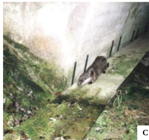
Figura nr. 5-8 A. Subtraversare adaptată pentru particularitățile de deplasare a mai multor specii; B. Zona de ieșire a unei subtraversări adaptată pentru mai multe specii; C: Exemplu de utilizare al unei pasarele de către un individ al speciei Lutra lutra
