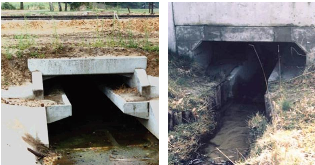
Figura nr. 5-7 Exemple ale unor subtraversări pentru specii de faună de dimensiuni mici, similare celor propuse ca măsură pentru menținerea conectivității (sursa: Iuell, 2003)
