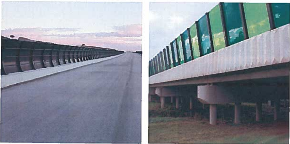
Figura 19. Exemple de panouri cu multiplu rol: reducerea nivelului de zgomot și lumină din vecinătate și a riscului de coliziune
