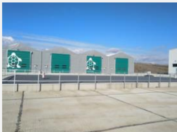
Stația TMB – tratare biologică
