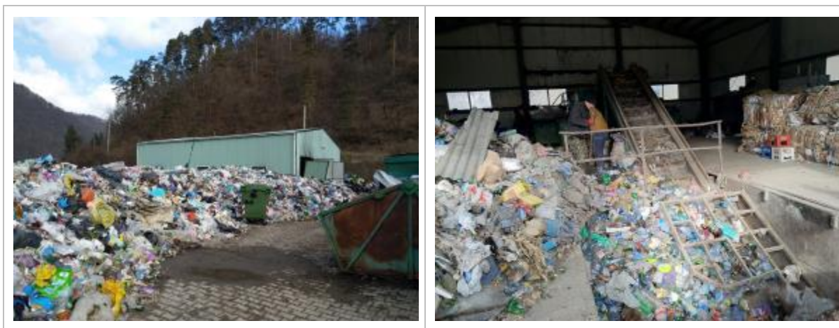
Figura 4 - 22: Stație de Sortare Baia de Arieș
