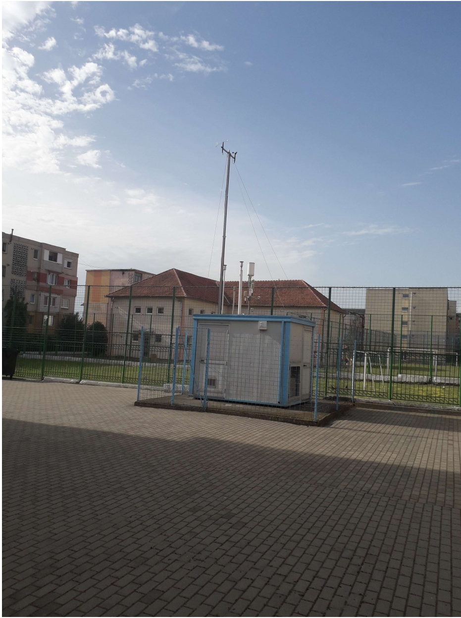
Stația automată AB-2 - tip industrial
