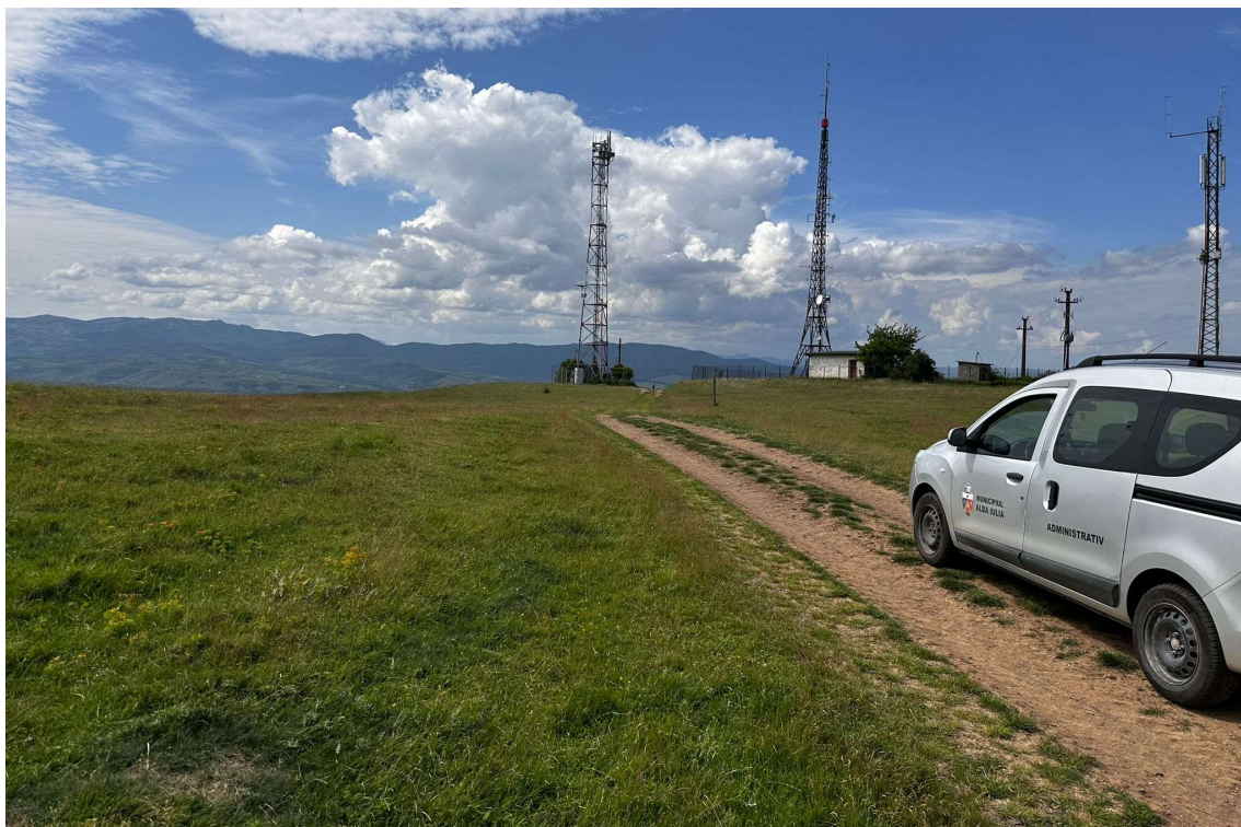
Fig. 5-6 Vedere din drumul de exploatare către NV: colțul de E al amplasamentului la stânga și stâlpii de telefonie existenți de-o parte și de alta a drumului
