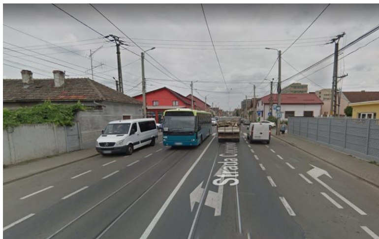
Figura 2.8.9.13. Str. Cocorilor - banda de circulație suprapusă peste linia de tramvai (câte 3,5 m/sens), piste de biciclete, benzi de parcare longitudinale, trotuare blocate de stâlpii de iluminat. Sursa: Google Maps.
