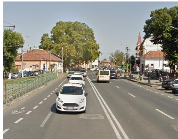
Figura 2.8.9.39. Pistă în carosabil, pe Str. Petru Rareș, prin afectarea benzii marginale și diminuarea capacității de circulație. Sursa: Google Maps.
