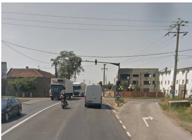
Figura 2.3.9.1.11. CNA, Intersecție semaforizată la intrare în Cartierul Gai (DN7 - Str. Poetului - DJ 709C), marcaj bandă viraj stânga șters. Sursa: Google Maps.
