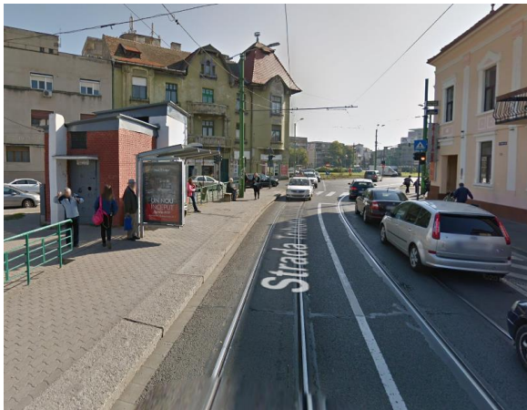
Figura 2.8.9.27. Linie de tramvai cu stație în carosabil, cu blocarea circulației pe timpul staționării. Sursa: Google Maps.
