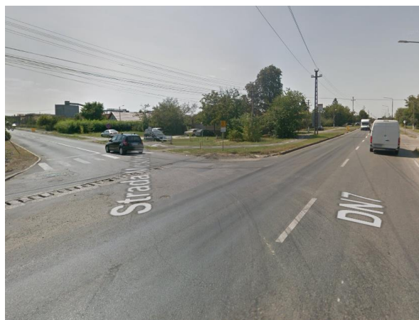
Figura 2.3.9.1.12. Intersecție CNA cu Str. Meșterul Manole neamenajată, viraje la stânga necontrolate, lipsă separatori de circulație. Sursa: Google Maps.
