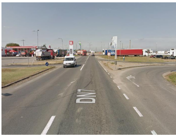
Figura 2.3.9.1.8. Bretele de intrare/ ieșire în stațiile de carburanți aproape de calea inelară, fără separator axial/ longitudinal pe brațul centurii. Sursa: Google Maps.
