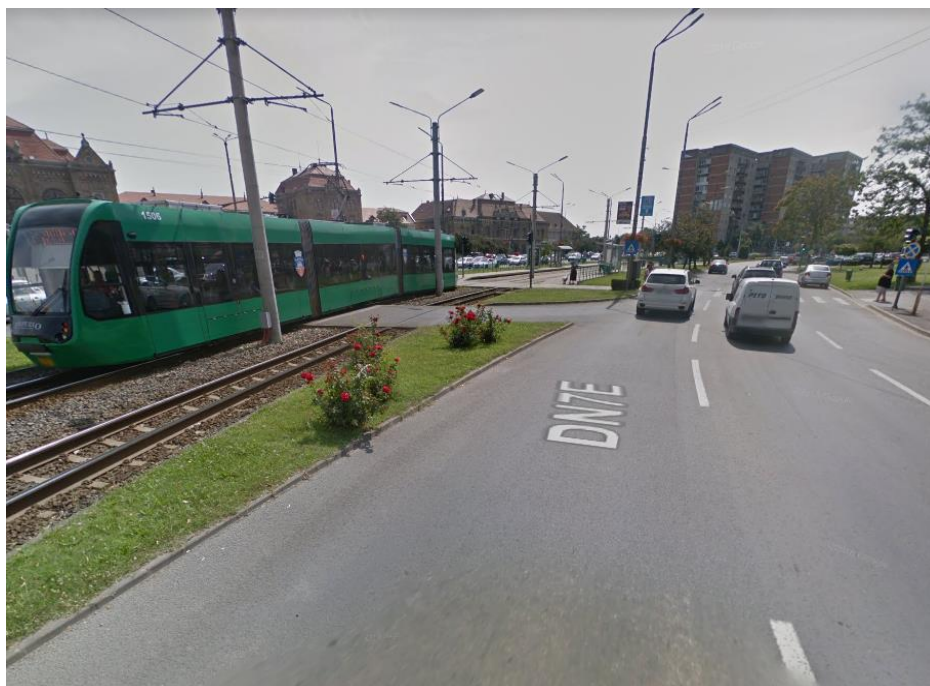
Figura 2.8.9.22. Linie tramvai în platforma proprie (reabilitată) în zona Gării Arad și tramvai nou, modern IMPERIO produs la ASTRA Vagoane Arad. Sursa: Google Maps.
