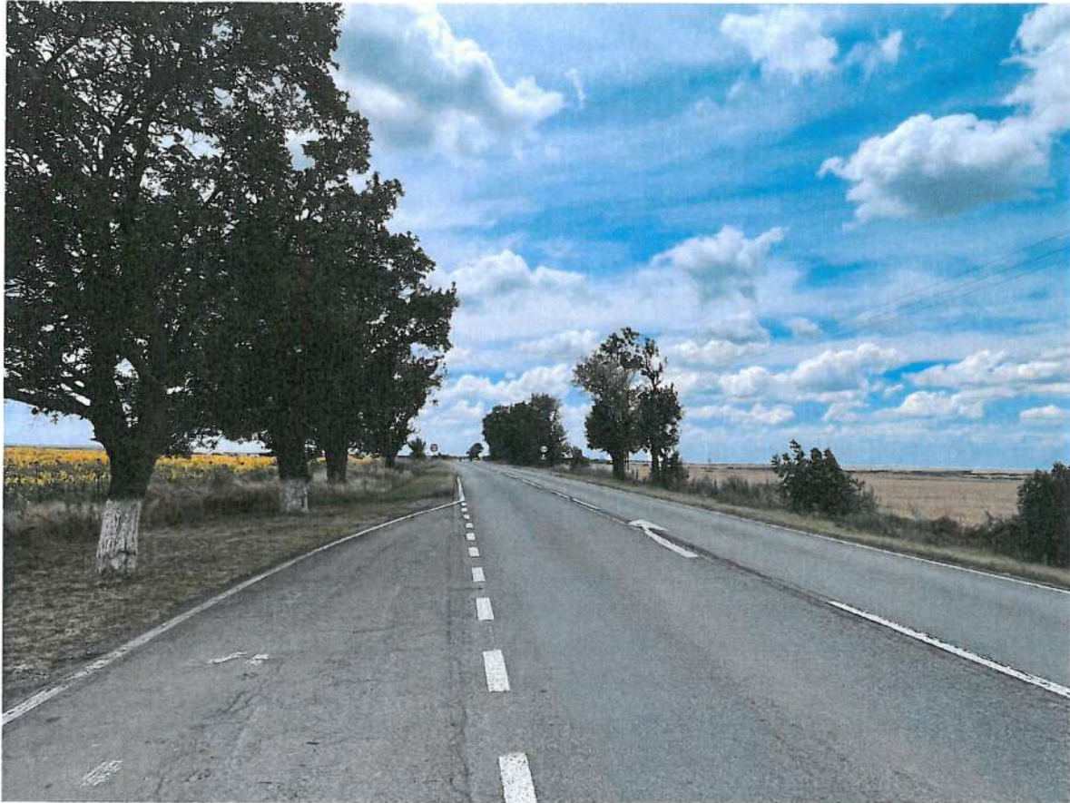
Imag. 7. - Amplasamentul propus, stânga - dreapta de DN69 Timișoara – Arad, terenuri deja antropizate, folosite ca terenuri agricole.
