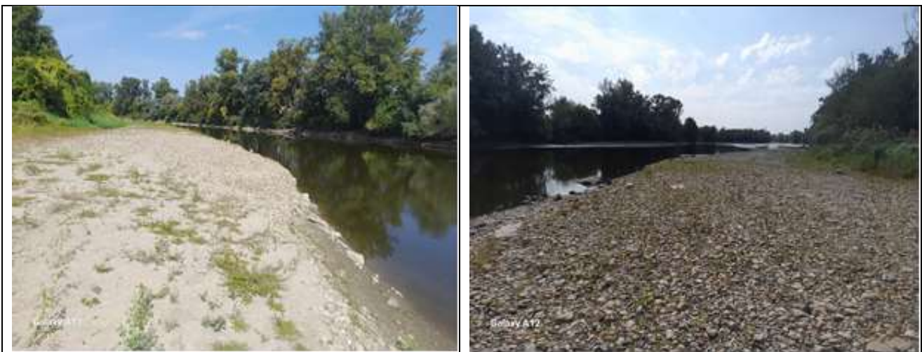
Figura nr. 7 Plaja inundabilă supusă decolmatării (vedere spre aval)
