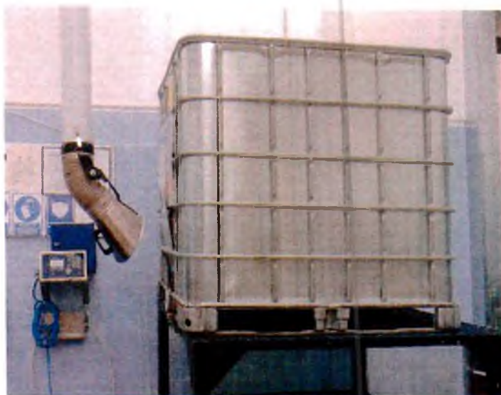
Foto 3 – Punct preparare cu sistem de aspiratie emisii gazoase
