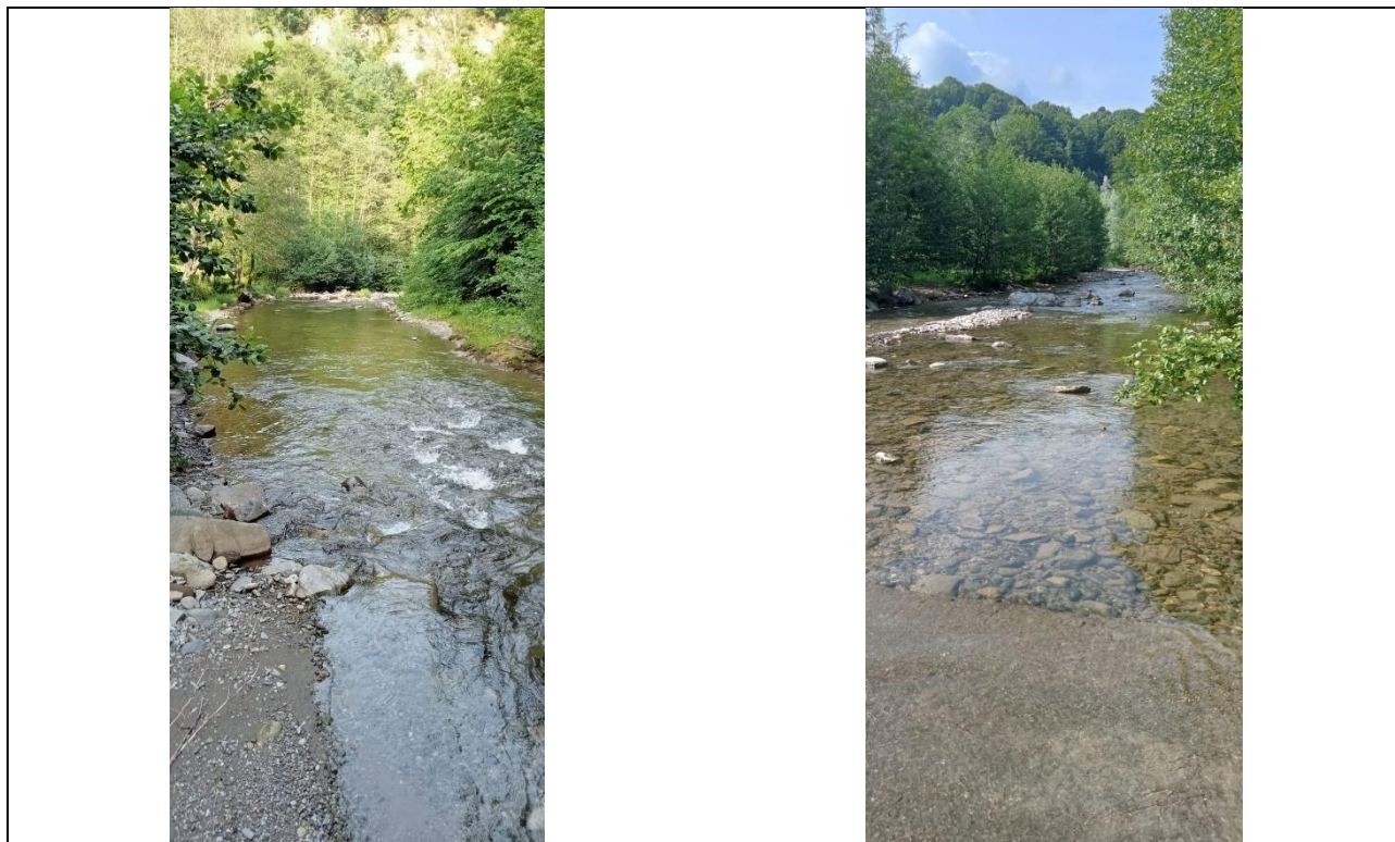
Foto 7. – aspect albie în zona pragurilor
