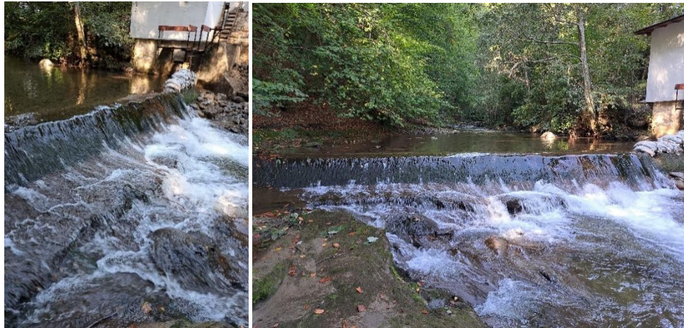
Foto 1. Vedere prag deversor priză captare a apei (P1)
