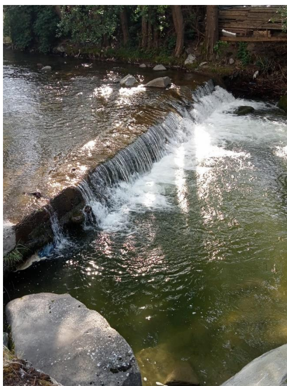
Foto 3. Vedere prag format de protecția din zidărie a rețelei de canalizare ce traversează râul Vâlsan (P3)
