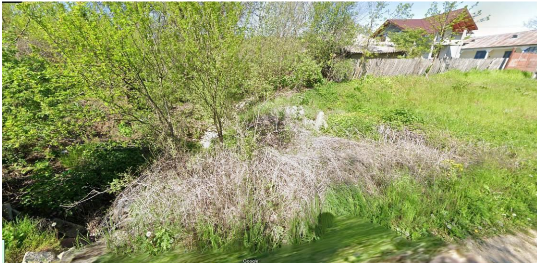
Vedere albie amonte de podetul tubular existent
