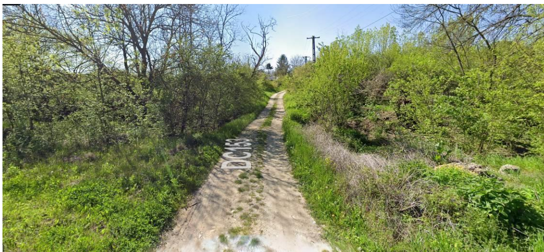
Vedere rampa drum – tehnic dreapta (cu acces din drumul principal)
