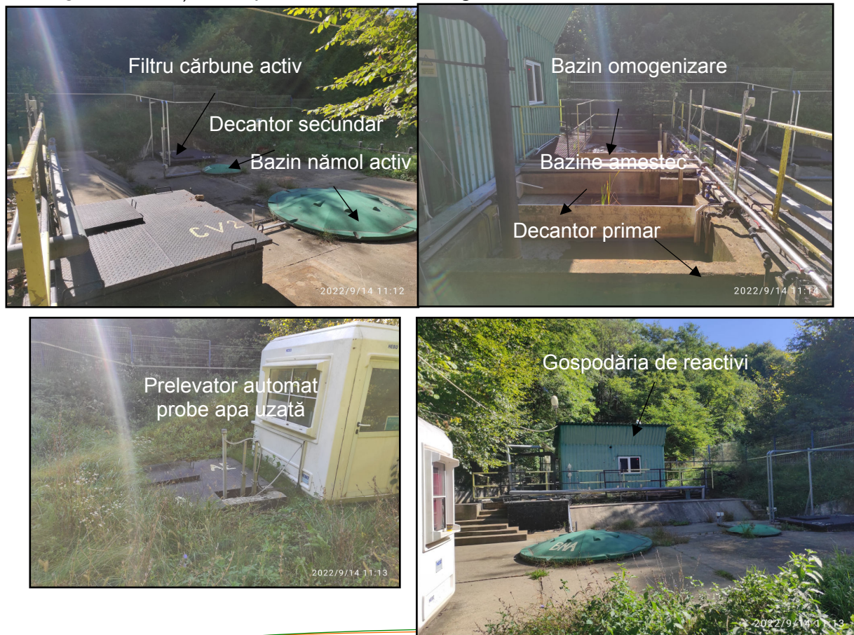
Figura 2 Stația de epurare mecano-biologică
