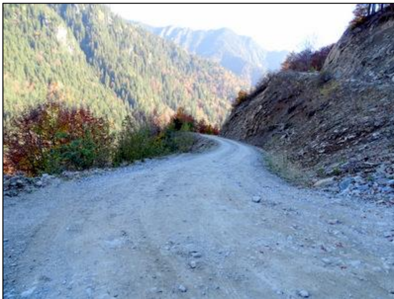
Figura nr. 6 – Aspect privind parte din sectorul cu serpentine al drumului forestier Piscul Hotarului, zonă vizată a fi evitată pe timp nefavorabil ca urmare a construirii drumului propus
