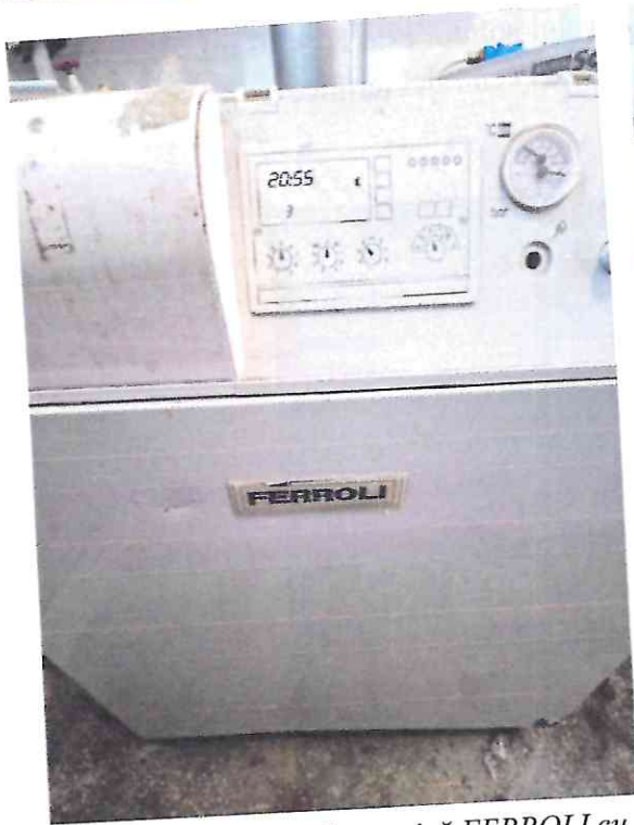
Figura nr. 10. Centrala termică FERROLI cu P = 100 \text{ kW} (pentru încălzirea cantinei)
