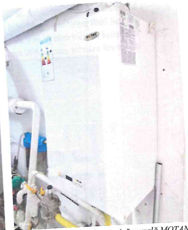
Figura nr. 11. Centrala termică murală MOTAN cu P = 24 \text{ kW} (pentru asigurarea apei calde la cantină)
