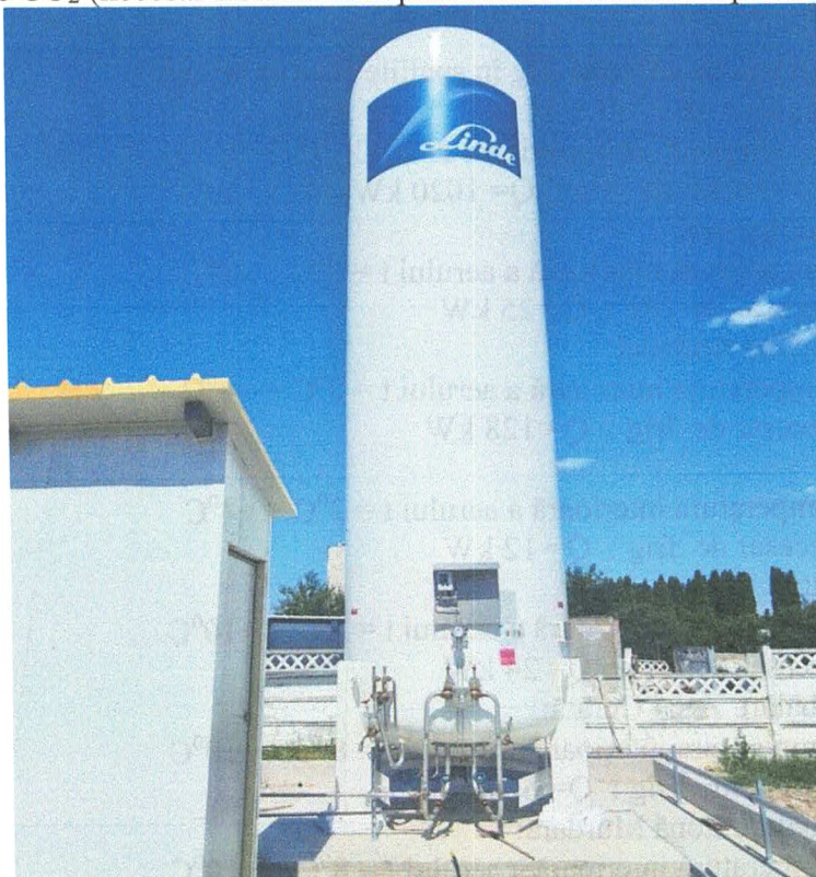
Figura nr. 14. Rezervor de \text{CO}_2
