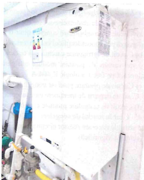
Figura nr. 11. Centrala termică murală MOTAN cu P= 24 kW (pentru asigurarea apei calde la cantină)
