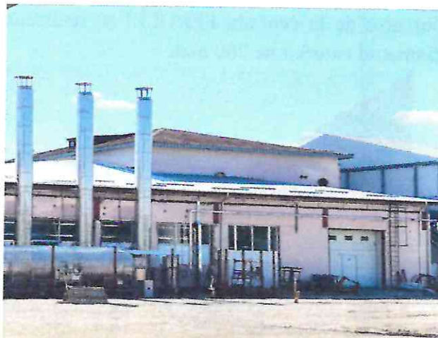
Figura nr. 9. Coșuri de evacuare gaze arse cazane VISSMANN VITOPLEX 200
