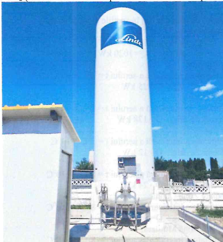
Figura nr. 14. Rezervor de \text{CO}_2
