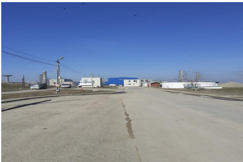
Foto. 12 Drumuri de acces interioare
