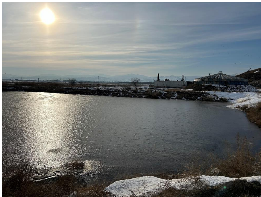
Foto. 15 Bazin de colectare permeat și ape pluviale
