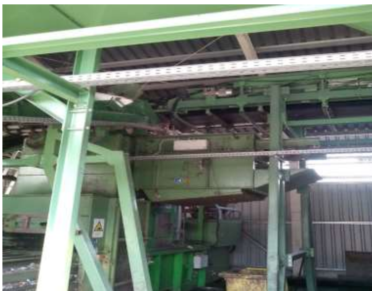
Fig. 5 - Presa de balotat si banda culisanta - Statia TMB
