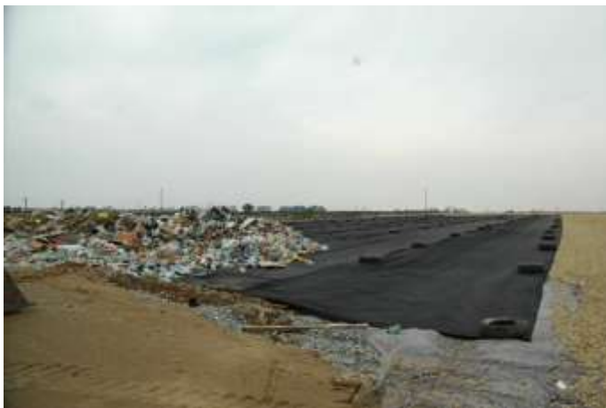
Fig. 7 – Celula de depozitare deșeuri
