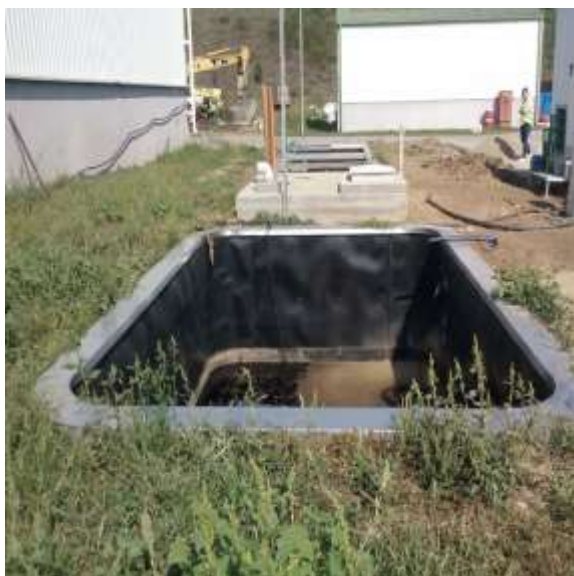
Fig.6, Bazin colectare concentrat-stație epurare levigat
