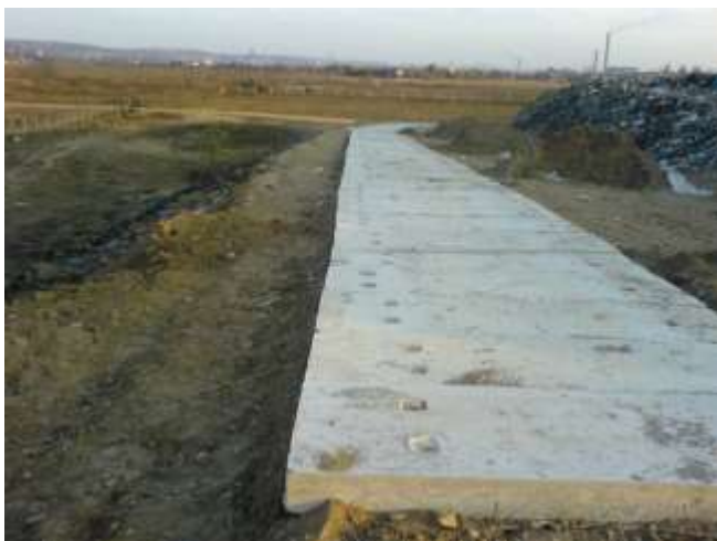
Fig. 12 – Rampa de acces în depozit
