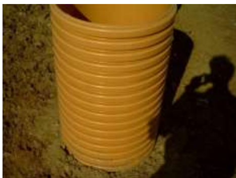
Fig. 10 – Cămin de curățire DN 315.
