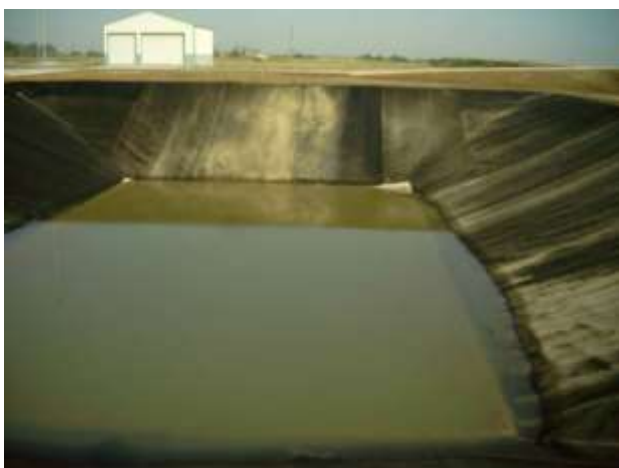
Fig. 8 – Bazinul de colectare levigat
