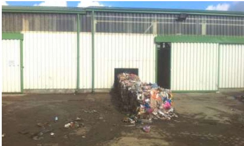
Fig. 4 - Eliminare baloti din Statia TMB
