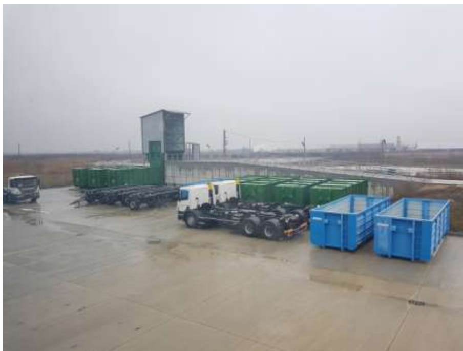
Fig. VII.1.1.5 Stație de transfer pentru precolectarea deșeurilor municipale - investiție realizată în cadrul proiectului Sistem de Management Integrat al Deșeurilor
