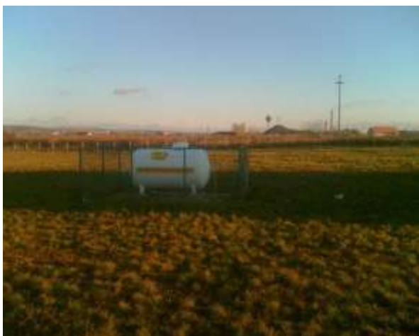
Fig. 10 – Rezervorul propan-butan
