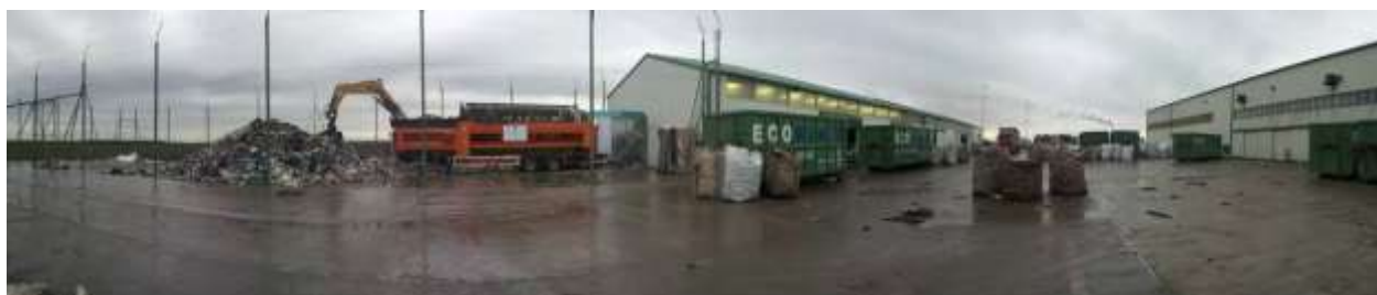
Fig. 1 – Stația TMB – Platfotmă de recepție deșeuri menajere
