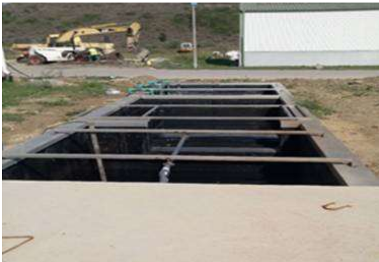
Fig.7- Bazine pretratare - statie epurare levigat
