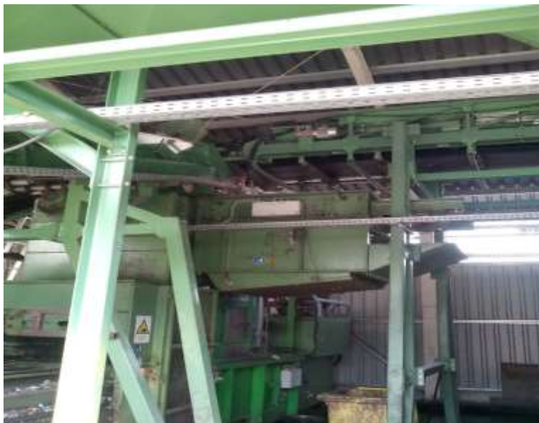
Fig. 4 - Presa de balotat si banda culisanta - Statia TMB
