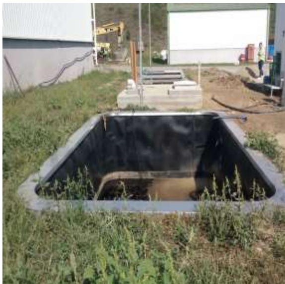
Fig.6, Bazin colectare concentrat-stație epurare levigat
