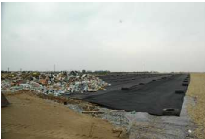
Fig. 6 – Celula de depozitare deșeuri
