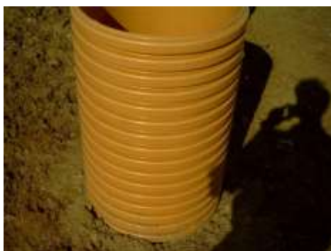
Fig. 8 – Cămin de curățire DN 315.
