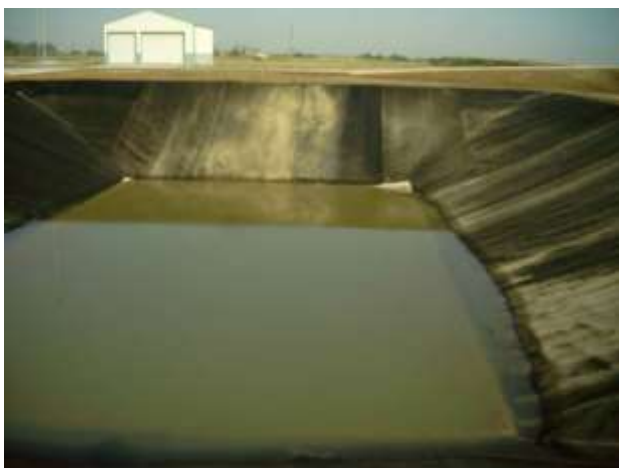
Fig. 7 – Bazinul de colectare levigat
