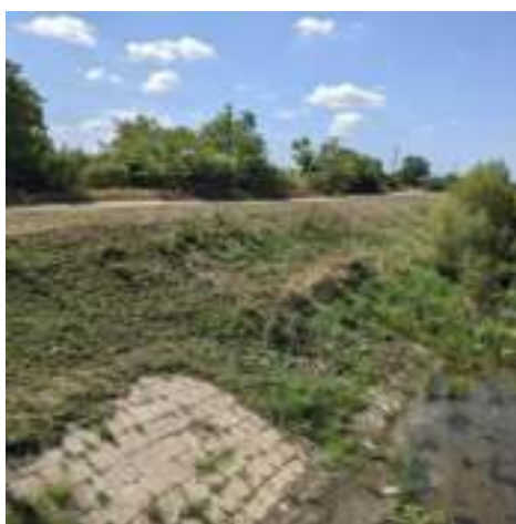
Obiectul 1. Dig mal stâng Valea Ier, sector Andrid-Ianca
