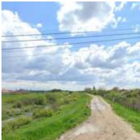
Obiectul 5 - Dig mal drept Canal Colector sector confl. V. Culișer
