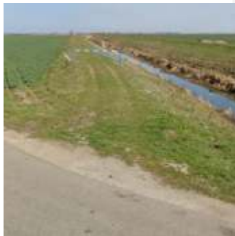
Obiectul 4 - Dig mal stâng râul Crișul Repede
