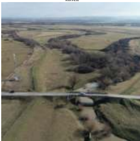
Obiectul 2 – Barcău-Pod DJ767A Saniob
