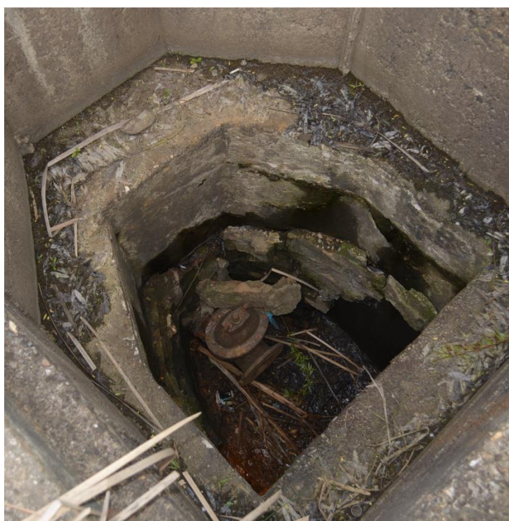
Situația existentă - turnul de manevra al deversorului degradat
