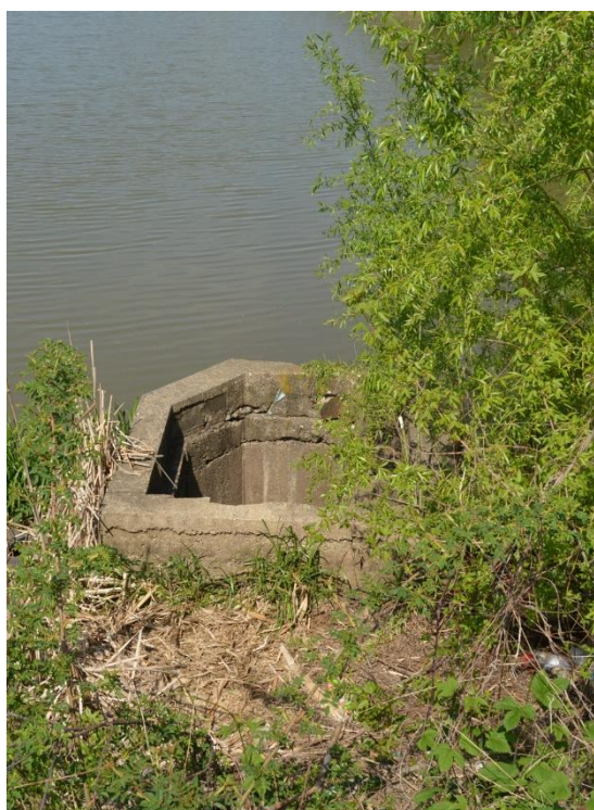
Situația existentă - turnul de manevra al deversorului degradat
