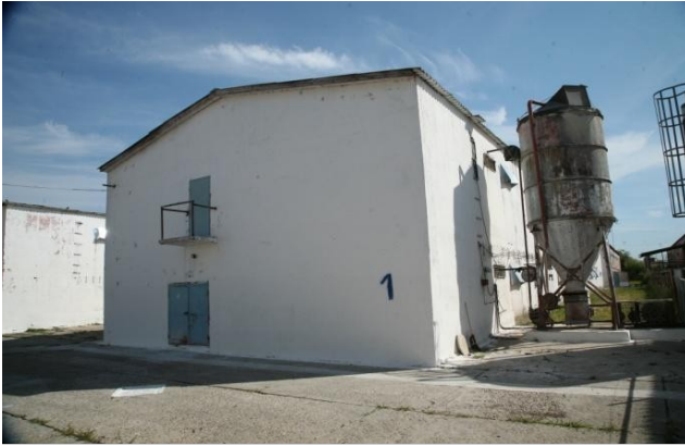
Bloc de creștere pui de carne
