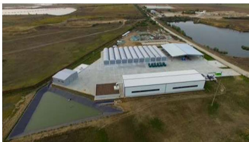
Stație de tratare mecano- biologică a deșeurilor municipale - investiție realizată în cadrul proiectului de Sistem de Management Integrat al Deșeurilor (Foto - Consiliul Județean Bihor)
