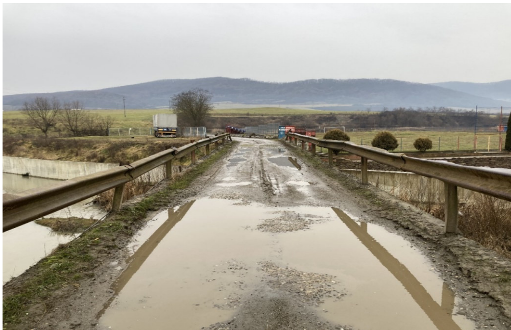
Foto nr.2 – vedere pod
