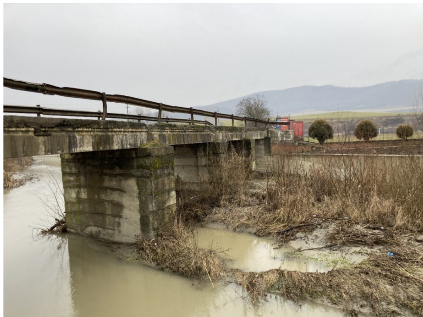
Foto nr.1 – Vedere dinspre aval(mal drept)
