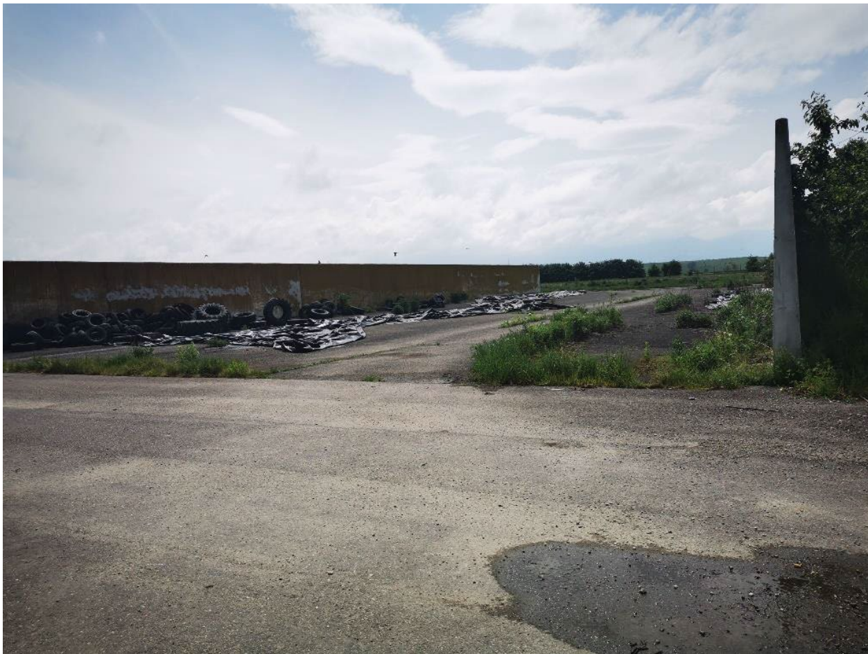
Fig.9 Platforme de insilozare și stație spălare mașini
