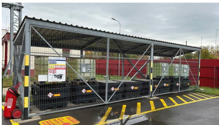
Foto – Zona exterioară depozitare substanțe chimice
