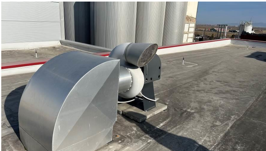
Foto - Exhaustor ventilaţie hala îmbuteliere PET
