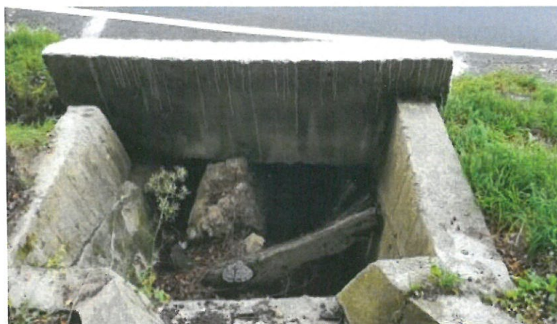
Foto – podet km 162+832 – camera de cadere amonte
