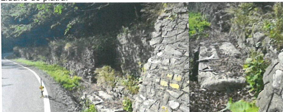
Foto – vedere podet partea amonte amplasat intre zidul de debleu de piatra si cel de gabioane
