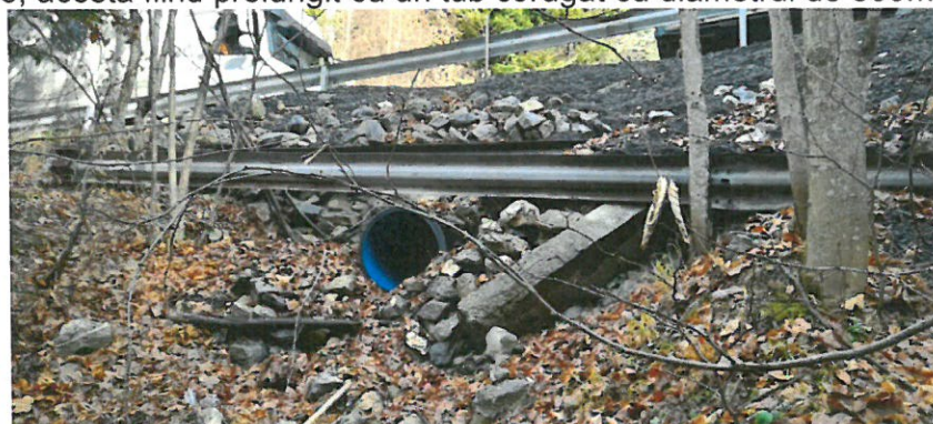
Foto –podet km 163+982 - partea aval, tub corugat pentru prelungirea podetului
