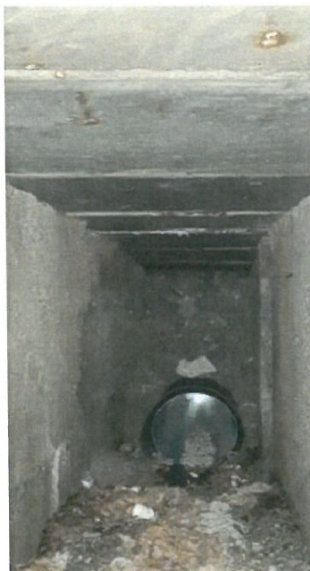
Foto – podet km 163+477 – vedere interior din amonte
