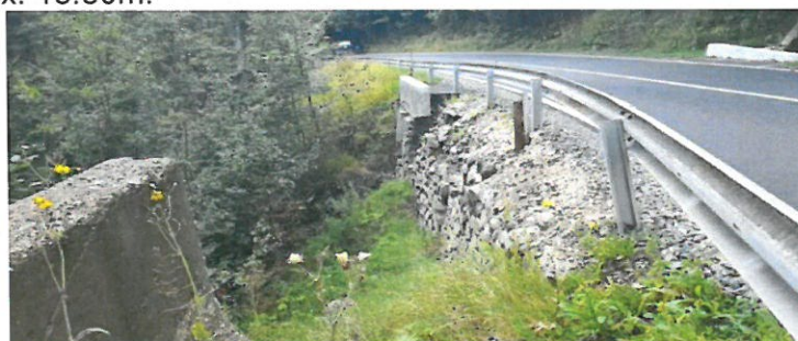
Foto –podet km 162+832 si zid din zidarie de piatra in partea aval
