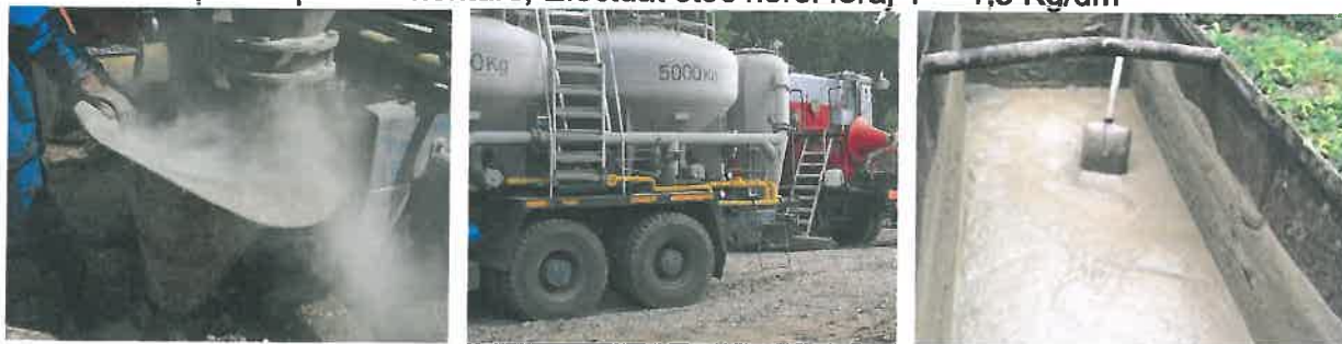
Imagile din timpul operatiilor de cimentare cu 1 to ciment tip G
