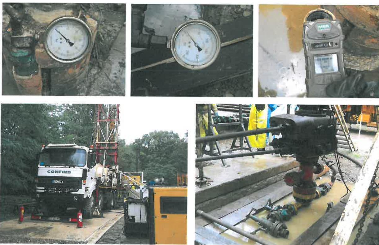
Situatia la sonda dupa verificarea presiunilor si a emanatilor de gaze din sonda si montare instalatie AM12 si prevenitor eruptie
