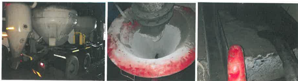
Operatia de cimentare cu 0,9 to Interval 50 – 0 m
