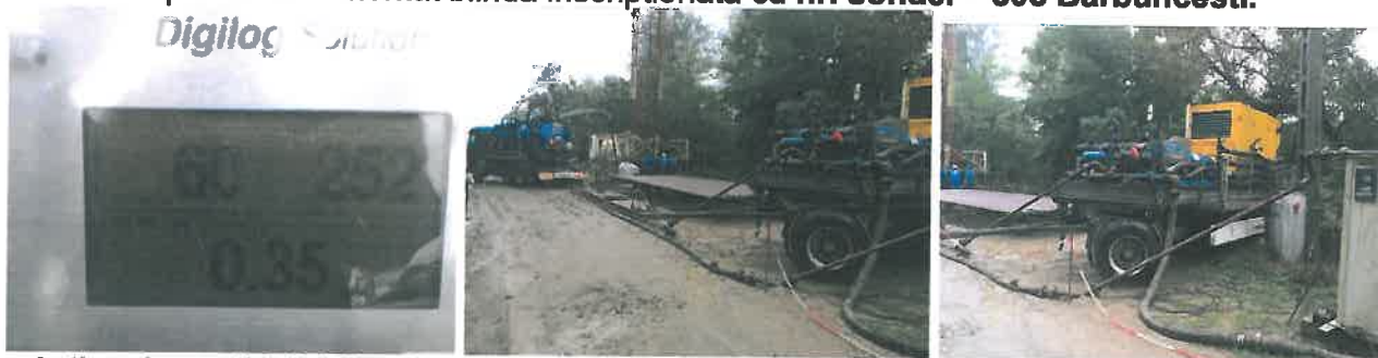
In timpul operatiilor de inlocuire apa sarata cu noroi foraj Y = 1,30 \text{ Kg/dm}^3 proba de presiune la 60 bar
