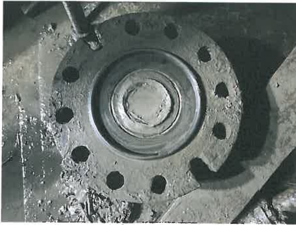
Cimentul de la gura sondei si montarea blindel inscriptionate
