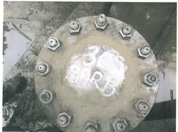
Cimentul de la gura sondei si montarea blindel inscriptionate
