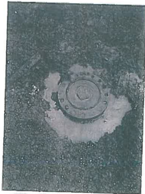
Fig. 12,13. Capul coloanei 4 1/2 completat cu ciment la zi.
