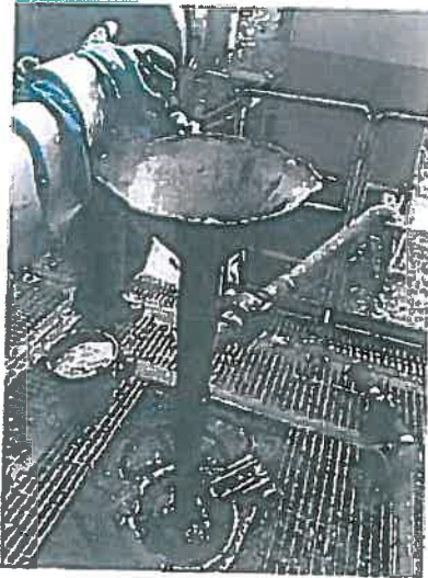
Fig. 8,9,10,11. Cimentare coloana 4 1/2 de la 140 m la zi
