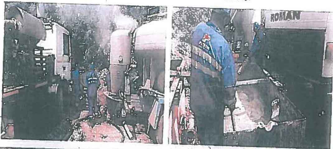
Fig. 7,8,9. Cimentare coloana 4 1/2 de la 88m la zi.
