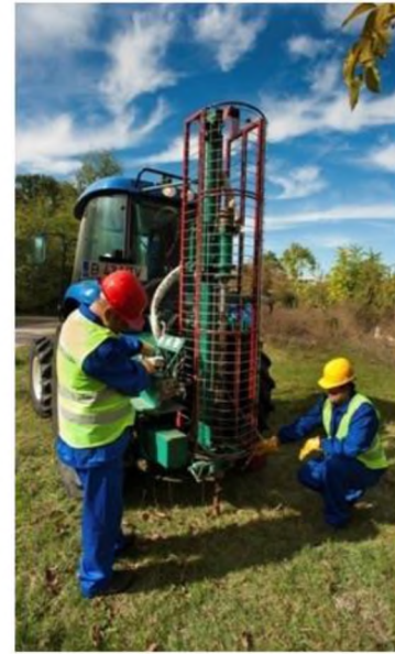
Fig. 7: Realizarea mecanică a găurilor
