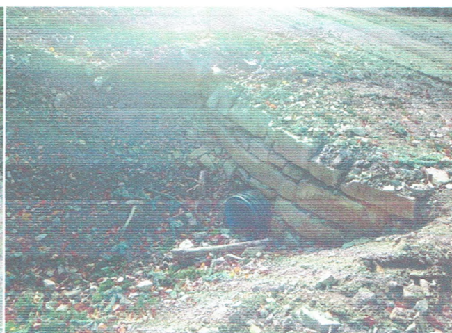
Fig. 9. Racordare aval podeț tubular descărcare șanț
