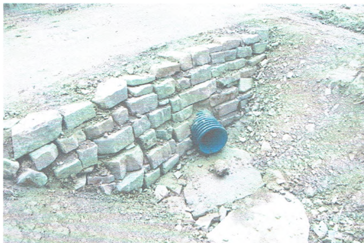
Fig. 10. Radier amonte podeț tubular
