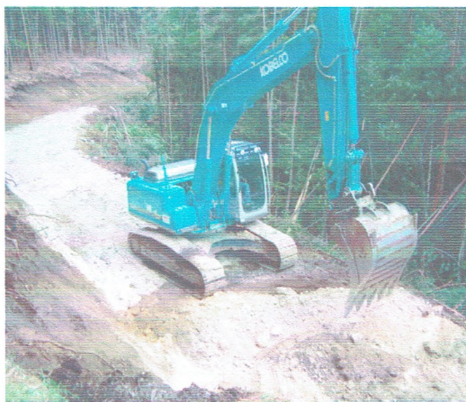
Fig. 6. Excavator în funcționare normală
