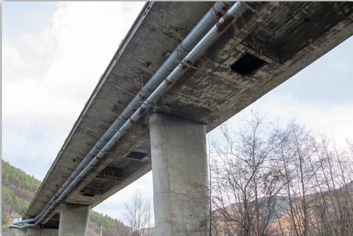
Podul existent pe DJ203K, km.127+550, peste raul Buzau
