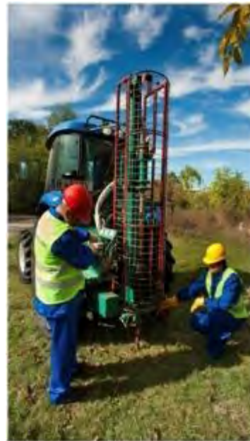
Fig. 7: Realizarea mecanică a găurilor
