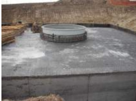
Fig . 8-fundatie turbine eoliana- foto original Badea Gh. .
