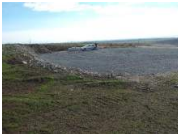
Fig.7- platforme de lucru -foto original Badea Gh.
