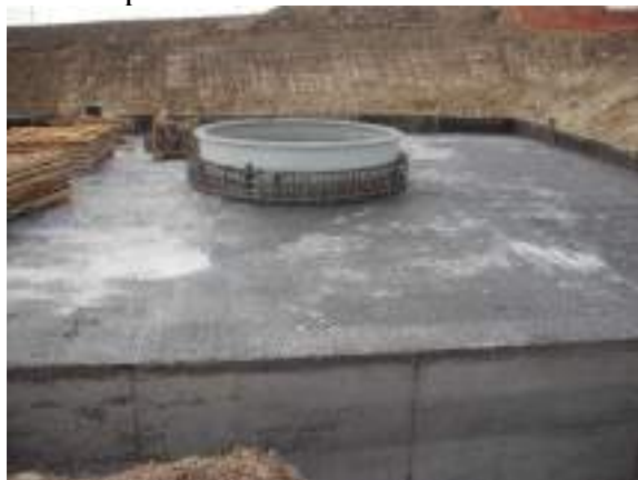
Fig .9- fundatie turbine eoliانا- foto original Badea Gh. .
