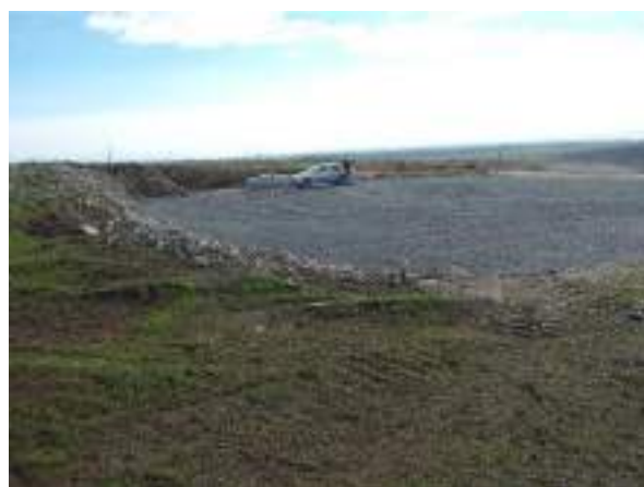
Fig.8- platforme de lucru -foto original Badea Gh.
