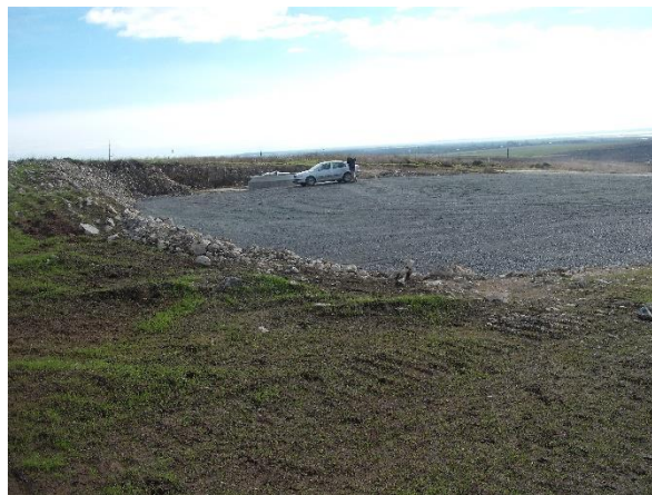
Fig.7- platforme de lucru -foto original Badea Gh.
