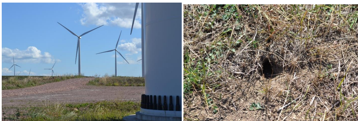
Fig. 25-26- Platforma turbina eoliana ( parc eolian in functiune din 2013 , care a fost construit pe terenuri arabile ) pe amplasamentul careia s-au identificat galerii ale speciei Spermophilus citellus
