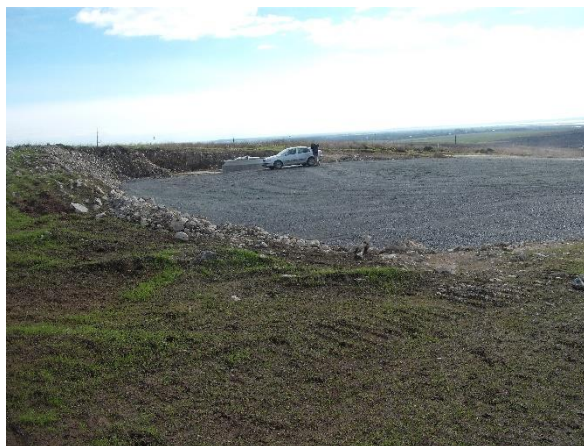
Fig.8- platforme de lucru -foto original Badea Gh.
