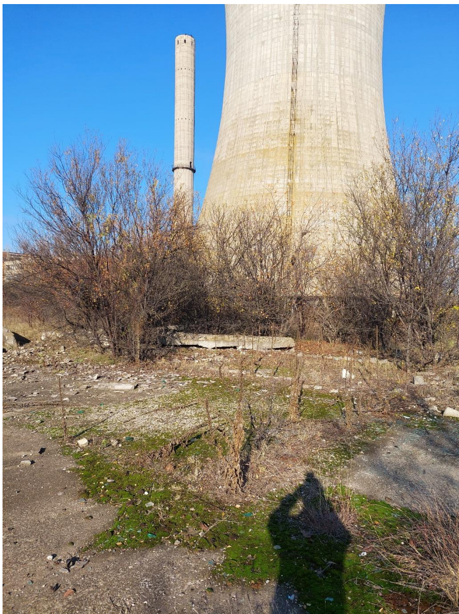
Turn de răcire nefuncțional (vedere dinspre est)
