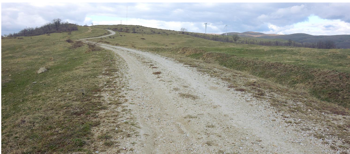
Figura 20. Vedere generală a zonei cu traseul drumului de exploatare existent în zonă, lateral cu aspectul general al habitatului 6210, © foto original
