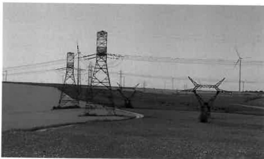
Foto peisaj din zona amplasamentului
