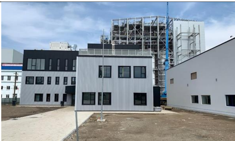
Fotografie nr. 3 - Clădire administrativă
