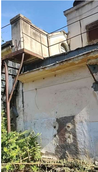
C21–Hala fabricatie (vedere latura Sud)
