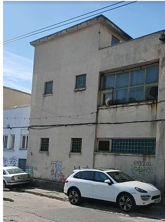
C21–Hala fabricatie (vedere latura Nord)
