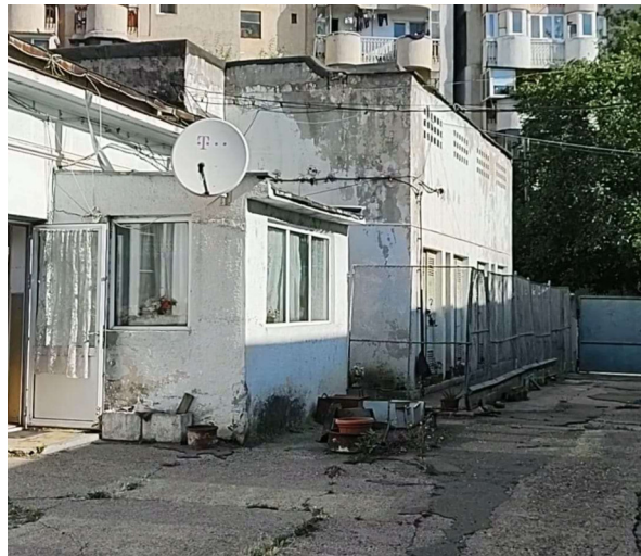
C15–Post trafo C16 –Statie pompe poarta
