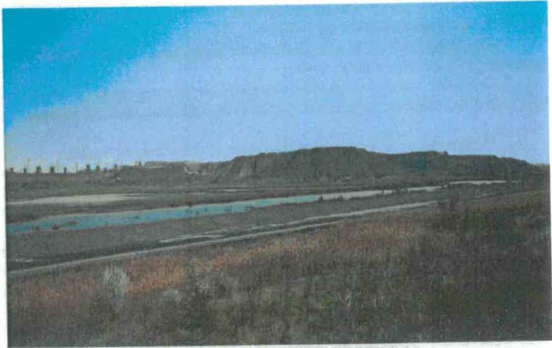
Figura 23 –Diguri perimetrare iaz Mălina Nord
