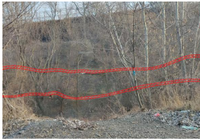
Fig. 9 Trasee spontane pentru circuit biciclisti întarite cu o structură de lemn.
