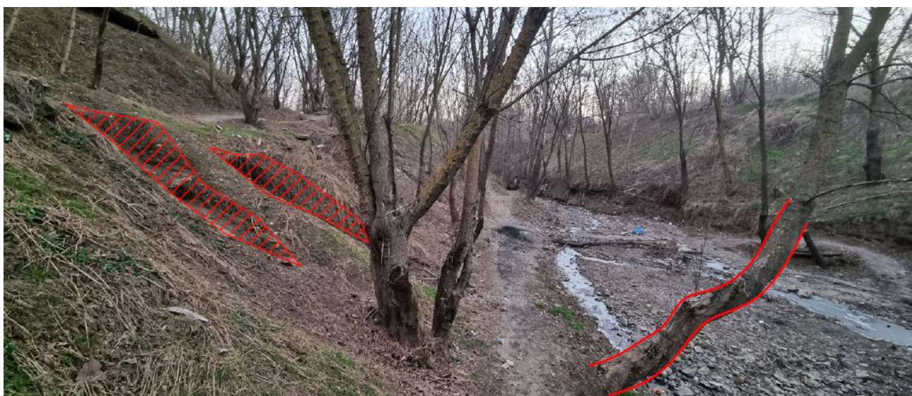
Fig. 47 Degradarea fizica a solului cauzata de calcare, de siroirea apelor pluviale. Afectarea vegetatiei.
