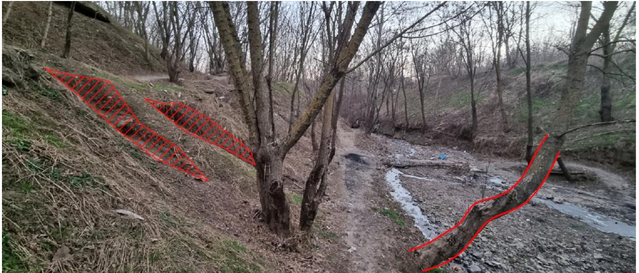
Fig. 35 Degradarea fizica a solului cauzata de calcare, de siroirea apelor pluviale. Afectarea vegetatiei.
