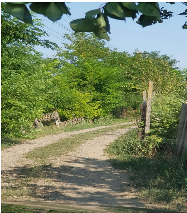
Foto 03. Situatia existenta a strazilor
