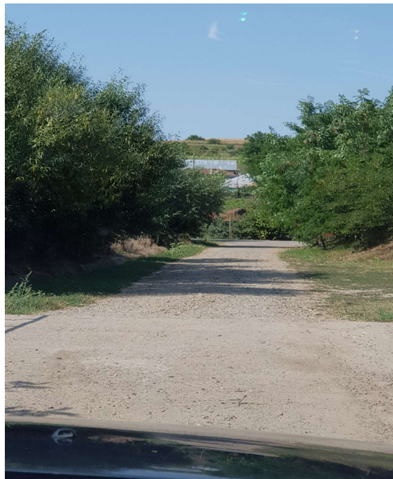
Foto 04. Situatia existenta a strazilor
