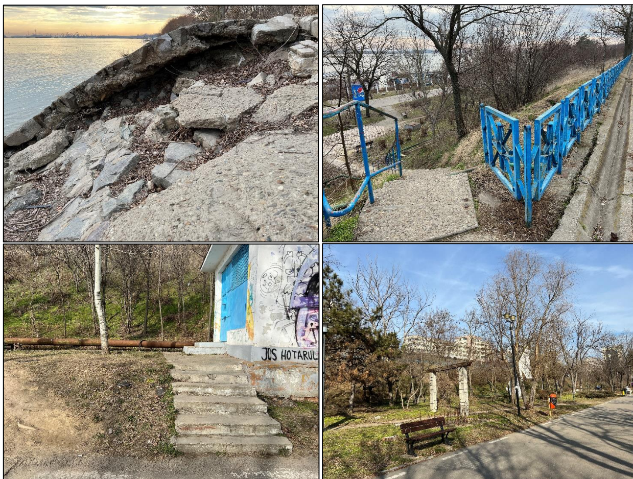
Fig. 23 Mobilier si elemente constructie- situatie existenta
