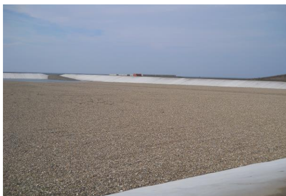
Depozitul de deșeuri industriale nepericuloase OMV Petrom
